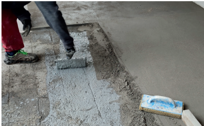
Posa della boiaccia di aggrappo con Lattice CentroStorico per la posa in aderenza del massetto delle pendenze QuotaZero.
