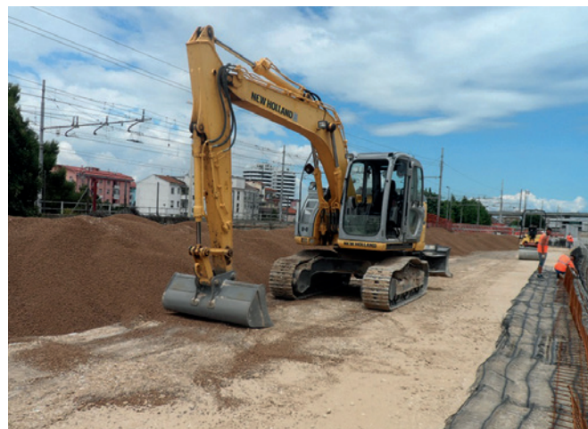
Pescara Porta Nuova - Rilevato ferroviario
