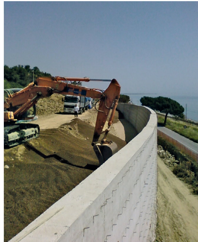
SS 106 Ionica - Riempimento dietro muro di sostegno.
