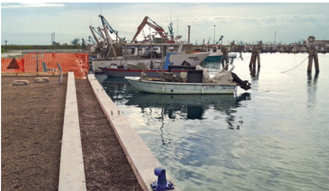
Ampliamento banchina porto di Goro (FE).
