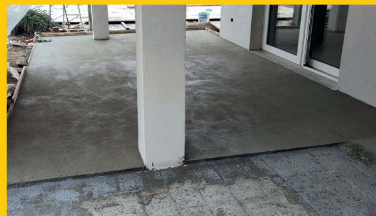
Posa del massetto QuotaZero con le normali tecniche dei sottofondi. Si possono realizzare sino a 50 m 2 senza giunti.
