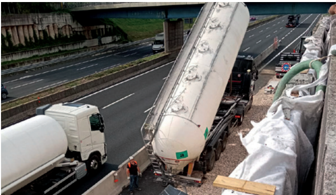
Autostrada A1, San Vittore - Riempimento dietro paratie di pali
