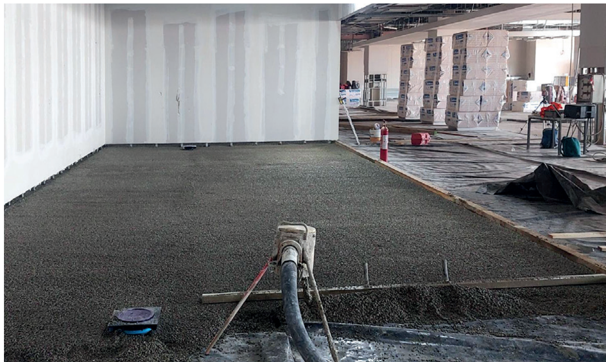
Posa dello strato di alleggerimento in Lecacem Classic, sottofondo leggero a base argilla espansa LecaPiù a grana media e a veloce asciugatura.
