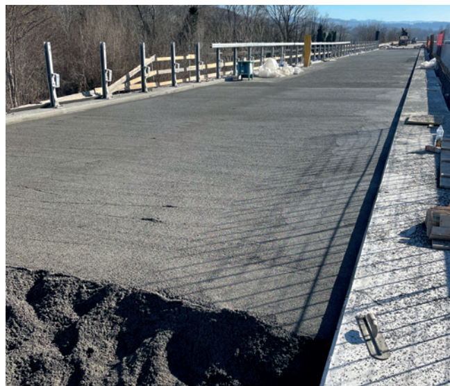
Massetto alleggerito su ponte E45 a Umbertide (PG).
