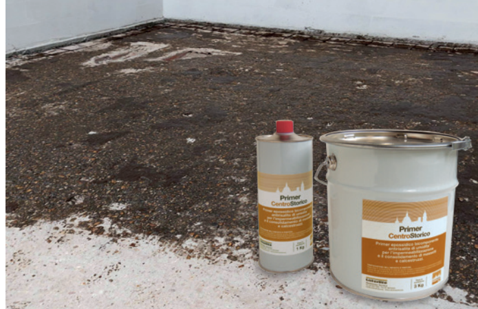
Preparazione del supporto con Primer CentroStorico.
