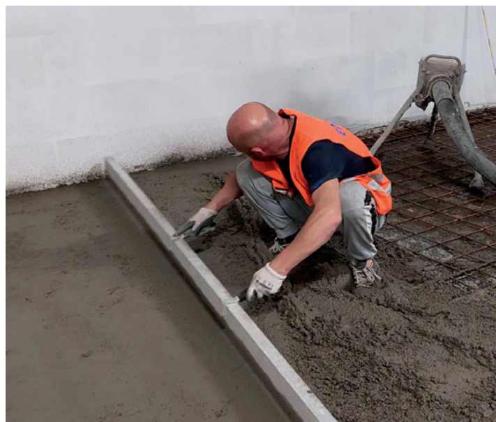
Posa fresco su fresco del calcestruzzo leggero strutturale LecaCLS 1400 su superficie trattata con Connettore CentroStorico Chimico.
