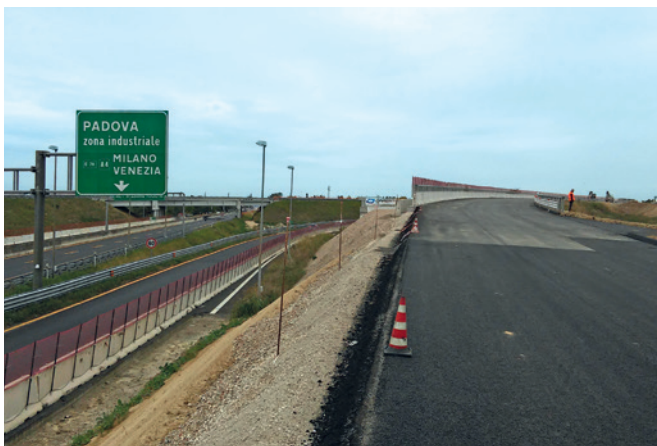
A4-A13 - Rilevato stradale
