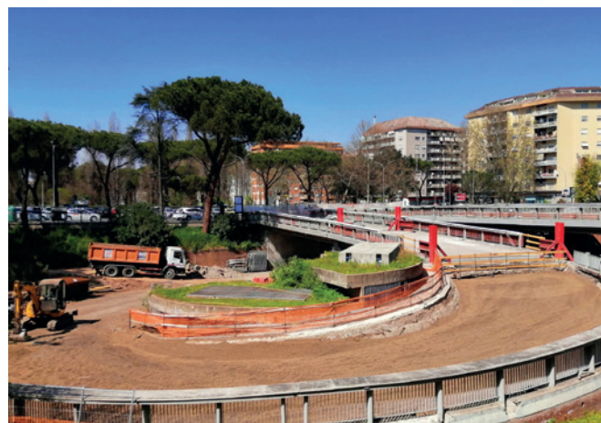
Roma EUR - Rilevato stradale
