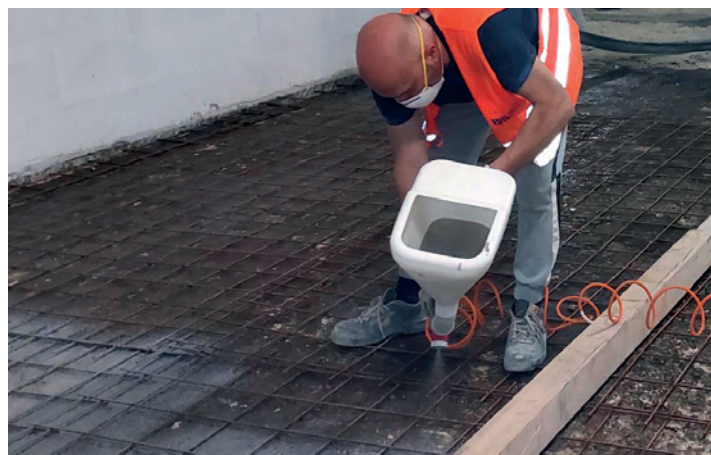
Posa del Connettore CentroStorico Chimico con lancia a tramoggia.
