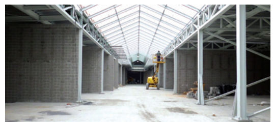
Centro commerciale Adriatico Due - Portogruaro (VE)
