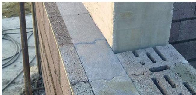
Parete di tamponamento con Lecablocco Bioclima Zero18P (setti in c.a. di spessore 25 cm).
