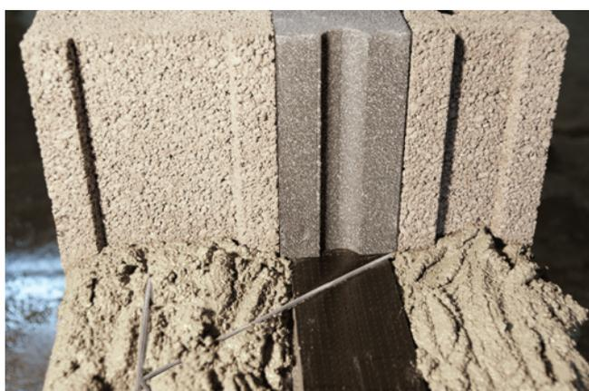
Posa del blocco con striscia isolante e traliccio metallico Murfor.
