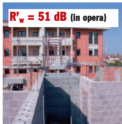
Palazzina a Ronchi dei Legionari (GO) Lecablocco Fonoisolante spessore 25 cm
