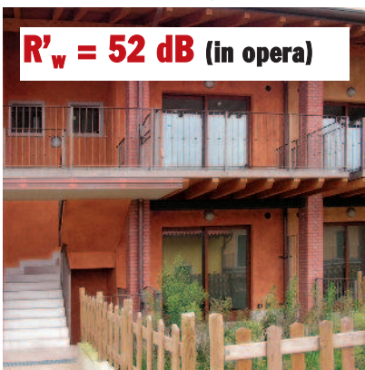
Villette a schiera Sandra (VR) Lecablocco Fonoisolante spessore 25 cm
