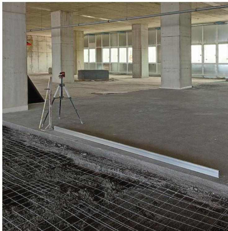
Anche il **sottofondo alleggerito Lecacem Classic** è stato apprezzato per la sua **veloce asciugatura, anche ad alto spessore**, e per le proprietà meccaniche determinate dalla presenza dell'argilla espansa Lecapiù.
