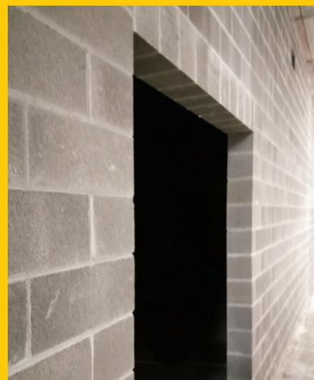
Parete in Lecablocco Tagliafuoco Facciavista con requisiti di resistenza al fuoco EI 120 e EI 240 per la centrale termica, locali interrati e isola ecologica.
