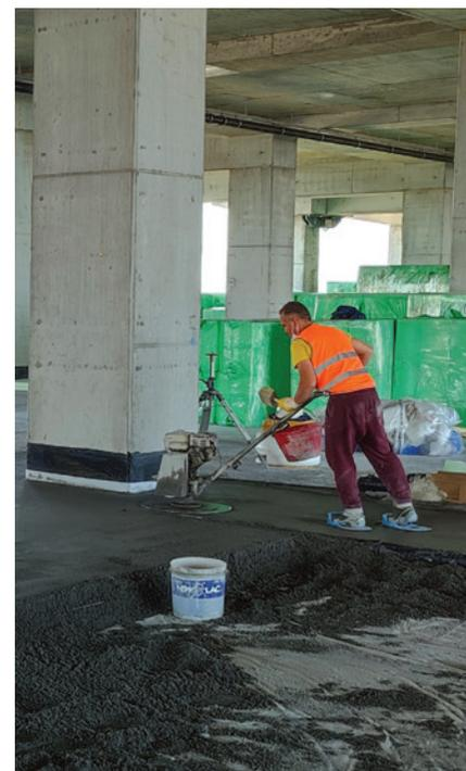
re i massetti anche ad altezze o a distanze elevate. Non dimentichiamo che l'altezza dell'edificio supera i 100 metri, basti pensare che le altezze interpiano dei primi dieci piani sono pari a ben 6 metri.
