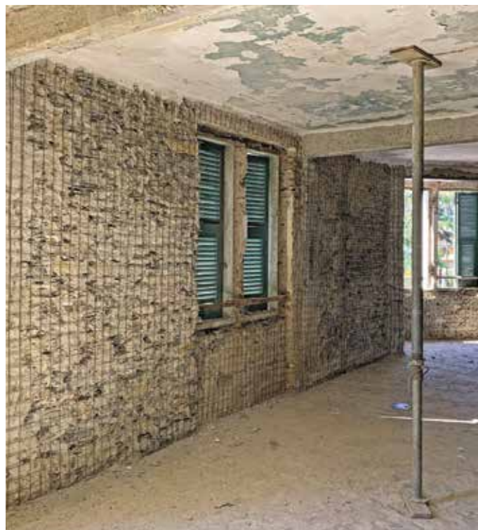
Intonaco Armato - CRM con rete G-Mesh 490 e malta MX-RW Alte Prestazioni per il rinforzo delle pareti perimetrali in sasso.
