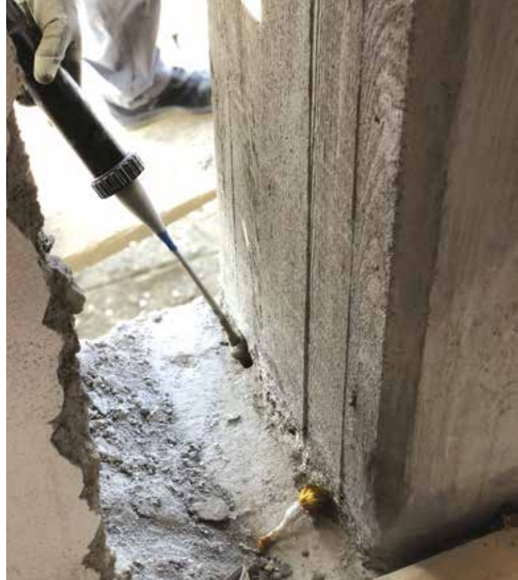
Applicazione del connettore PBO-Joint con l'apposita matrice MX-Joint.
