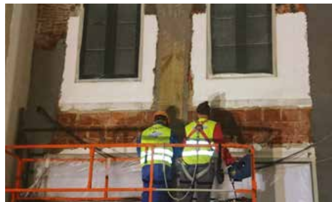
Dopo la posa del primo strato di PBO-Mesh si procede con la stesura del secondo strato di matrice inorganica MX-PBO Muratura.
