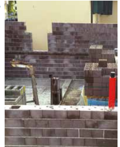
Muratura portante armata per le pareti perimetrali esterne e divisorie tra unità abitative in Lecablocco Bio-clima Sismico.
