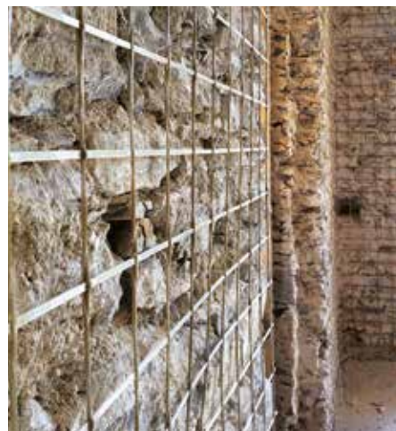
Intonaco Armato - CRM con rete G-Mesh 490 e malta MX-RW Alte Prestazioni per il rinforzo delle pareti perimetrali in sasso.
