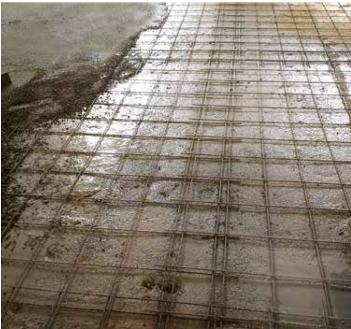
Connettore CentroStorico Chimico prima della stesura del calcestruzzo leggero strutturale LecaCLS 1600.
