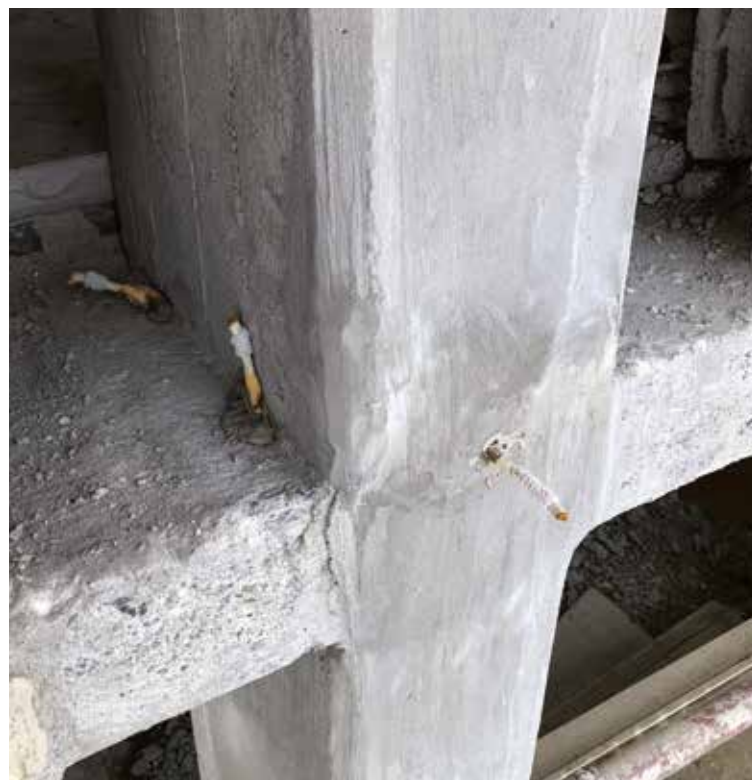
Applicazione del connettore PBO-Joint con l'apposita matrice MX-Joint.
