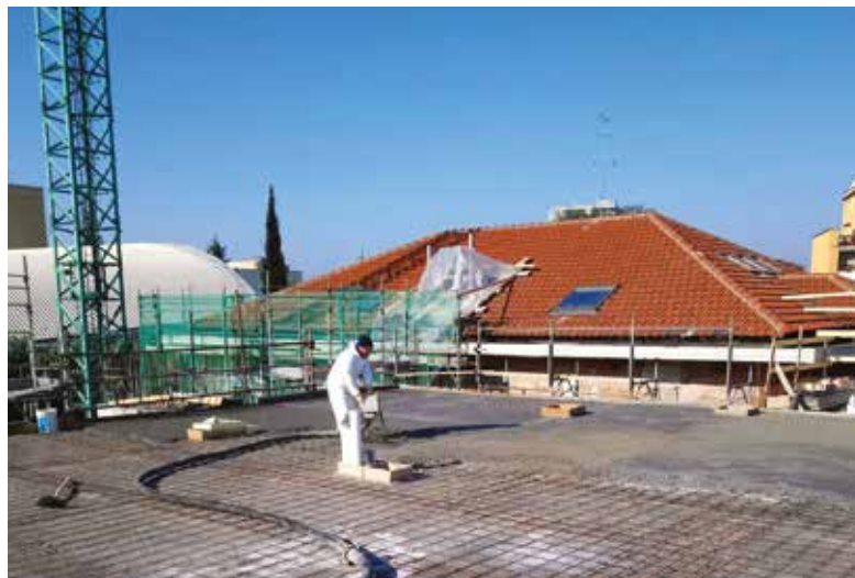
Consolidamento del solaio di copertura con realizzazione di soletta collaborante leggera con Connettore CentroStorico Chimico e LecaCLS 1600.
