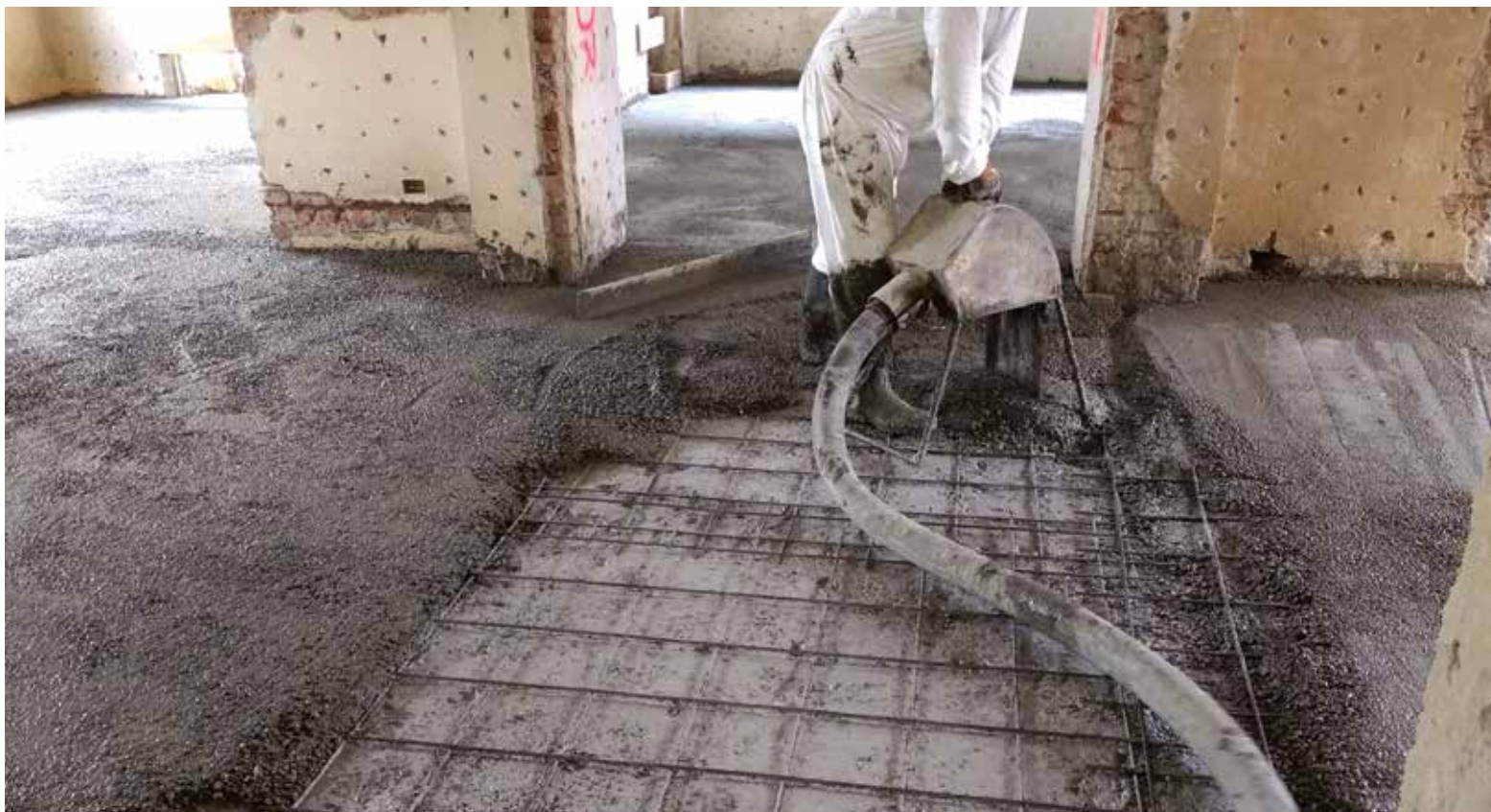
Posa della soletta collaborante in calcestruzzo leggero strutturale Leca-CLS1600 dopo la stesura del Connettore CentroStorico Chimico fresco su fresco per il consolidamento statico del solaio in laterocemento tipo SAP.
