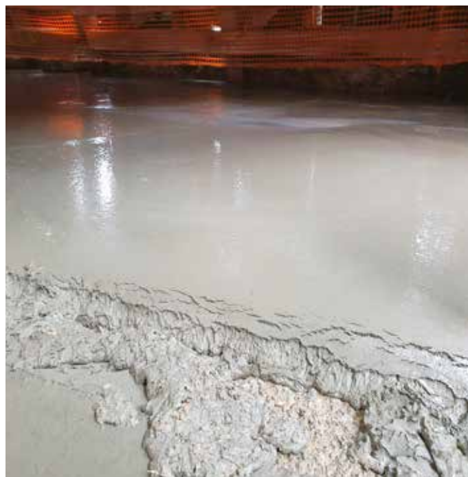
Consolidamento dei solai con microcalcestruzzo fibrorinforzato MICRO GOLD STEEL in aderenza posato nello spessore di 3 cm.
