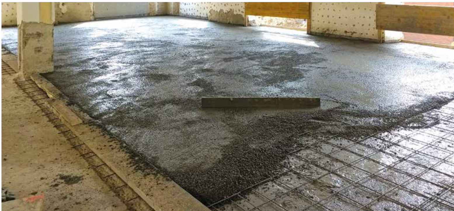
Consolidamento del solaio di copertura con realizzazione di soletta collaborante leggera con Connettore CentroStorico Chimico e LecaCLS 1600.
