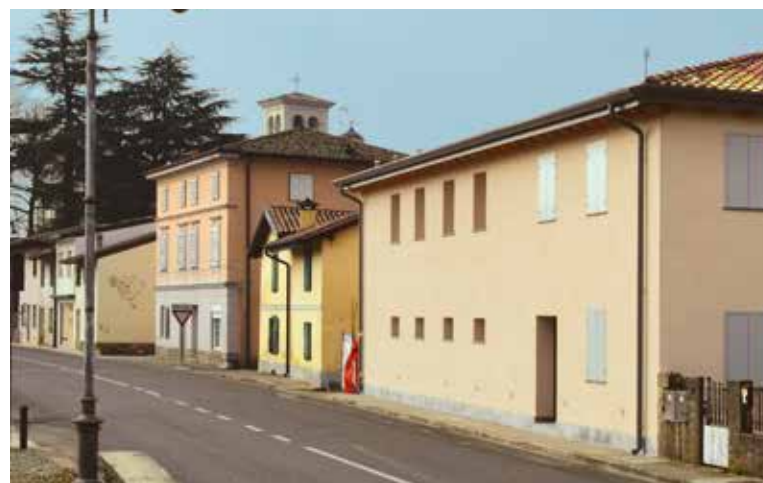
Ricostruzione dell'edificio residenziale in seguito alla demolizione.
