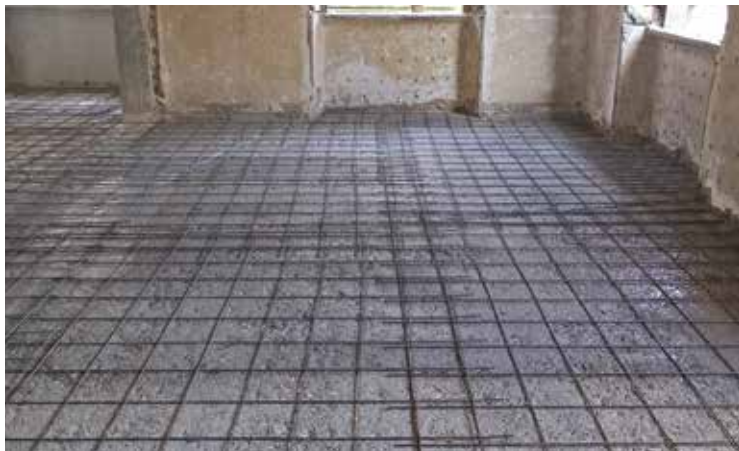
Posa della soletta collaborante in calcestruzzo leggero strutturale Leca-CLS1600 dopo la stesura del Connettore CentroStorico Chimico fresco su fresco per il consolidamento statico del solaio in laterocemento tipo SAP.
