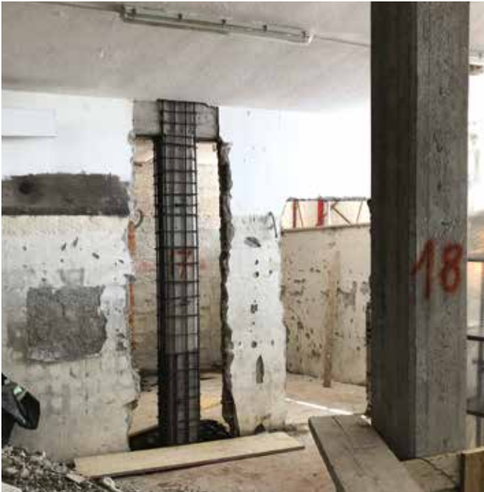
Ringrosso dei pilastri esistenti previa scarifica del copriferro, trattamento dei ferri di armatura esistenti con Passivante Ruregold, aggiunta di armatura supplementare e aumento della sezione con malta MX-R4 Ripristino.
