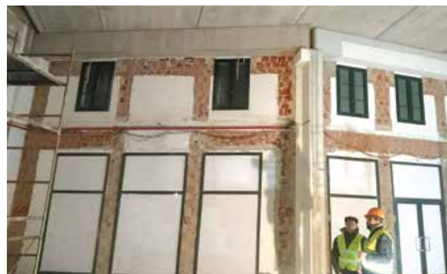
Preparazione del supporto: asportazione delle parti incoerenti, pulizia e bagnatura del supporto per la posa del sistema FRCM.
