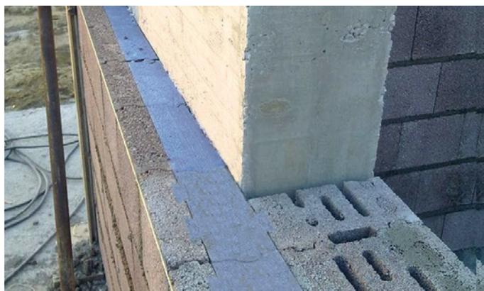
Parete di tamponamento con Lecablocco Bioclima Zero23P/S (setti in c.a. di spessore 25 cm).
