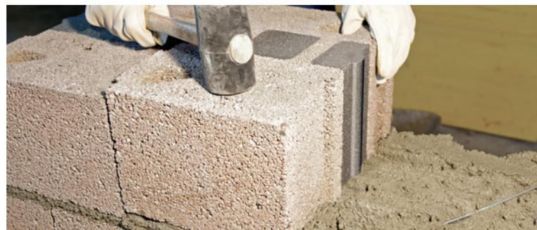
Posa del blocco con malta termica (Malta Leca M5 Supertermica).
