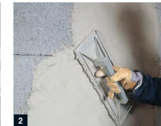
2. È possibile finire le pareti con una rasatura armata con rete in fibra di vetro.
