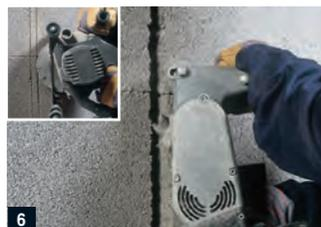
6. Esecuzione delle tracce impiantistiche con scanalato a disco o a fresa.
