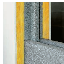
Placcaggio con pannelli preaccoppiati
