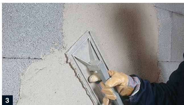
3. La parete, già a piombo, è intonacabile con uno strato sottile (0,5 cm), anche con la stessa Malta Universale Lecalite. Si consiglia di realizzare una rasatura armata con rete in fibra di vetro o similare in particolare per pareti esterne.
