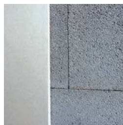
Placcaggio con cartongesso
