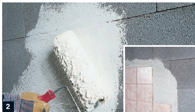
2. La planarità delle facce e l'assenza delle fughe permettono di tinteggiare direttamente la parete o di applicarvi un rivestimento in piastrelle.
