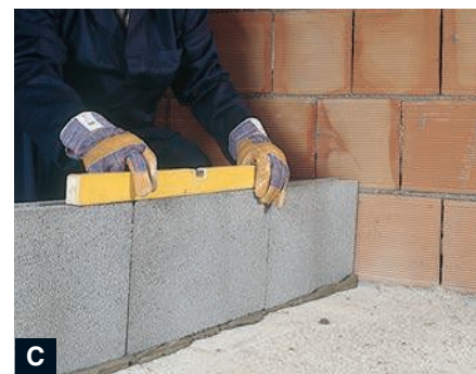
C. Controllare la posa in bolla del primo corso. Questa fase permette di posare a regola d'arte i corsi successivi.
