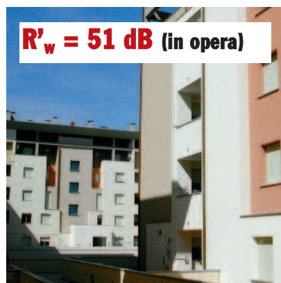
Palazzina a Firenze Lecablocco Fonoisolante spessore 25 cm
