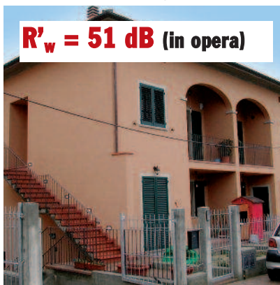
Palazzina a Monte San Savino (AR) Lecablocco Fonoisolante spessore 25 cm
