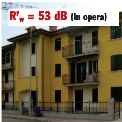
Palazzina a Novi di Modena (MO) Lecablocco Fonoisolante spessore 30 cm
