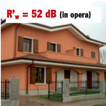
Palazzina a Reggiolo (RE) Lecablocco Fonoisolante spessore 30 cm
